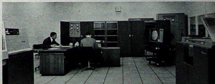
Bild 3. Blick in den Rechneraum mit Schnelldrucker (ganz links), „TR 4“-Rechner von Telefunken mit Kontrollpult (Mitte), Überwachungsgerät von Plessey und Lacharteneinheit (rechts)
